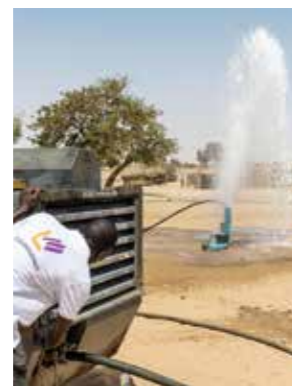
Provtäckning av brunn.
